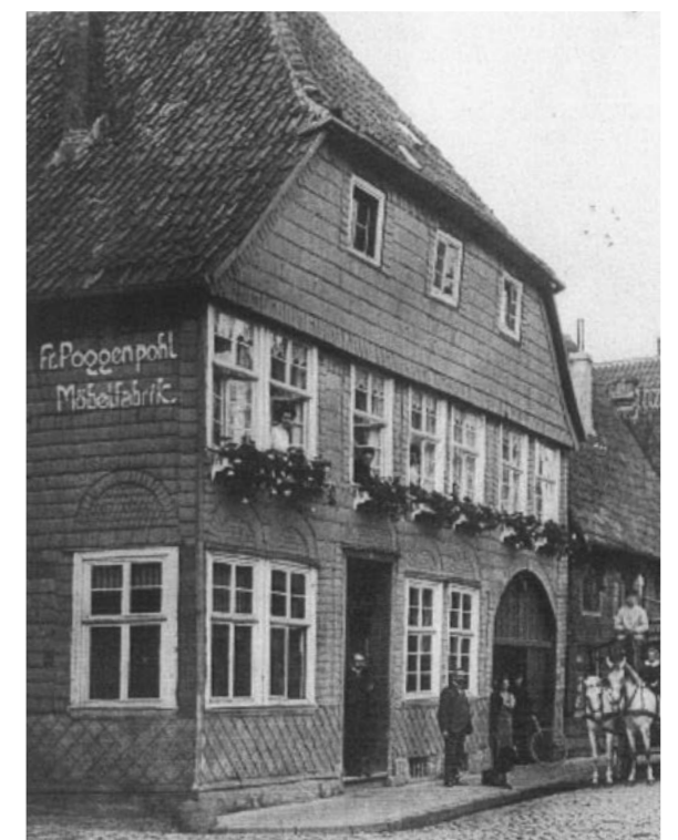
Erste Möbelfabrik Poggenpohl in Herford, um 1920.
